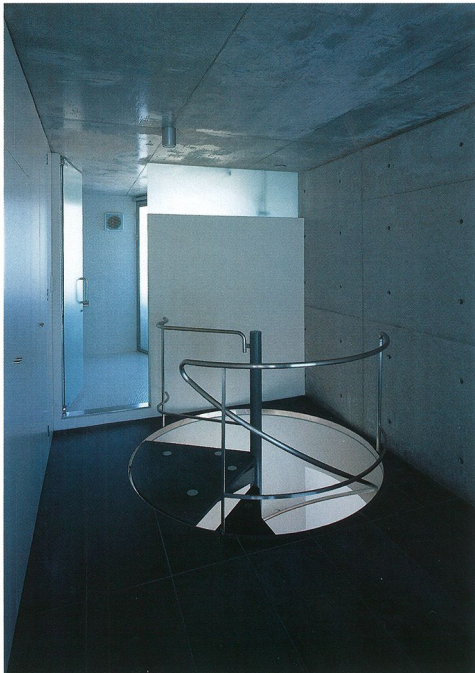
住戸玄関。すべての住戸は3階からアプローチし、2・3階と3・4階がメゾネットになっているユニットがし型に組み合わされている。
