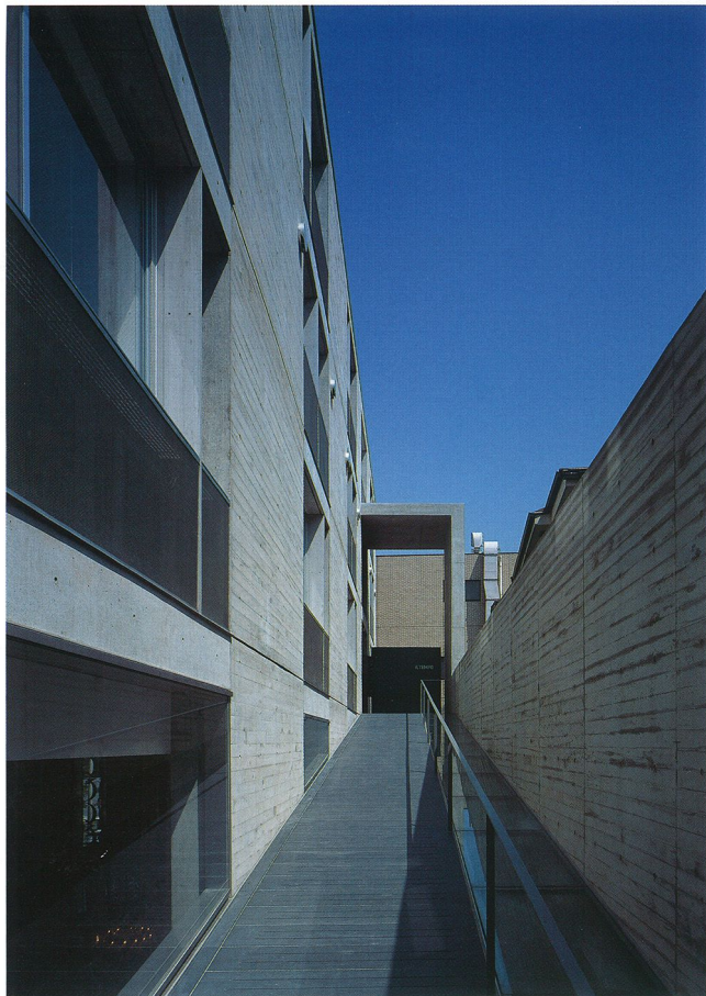
集合住宅へのアプローチ・スロープ。左手足下の開口から店舗が見える。
